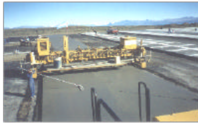
Figura Q.10 Equipo para texturizado y para curado.
