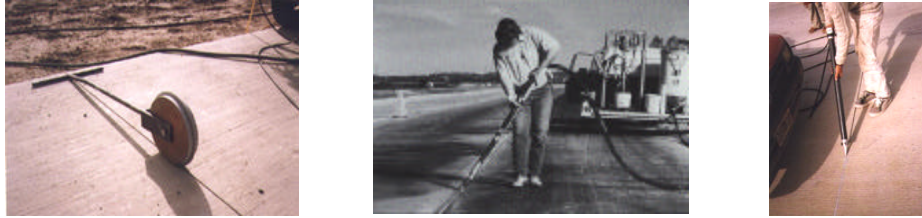
Figura Q.18 Colocación de cintilla de respaldo y sellado de juntas.
