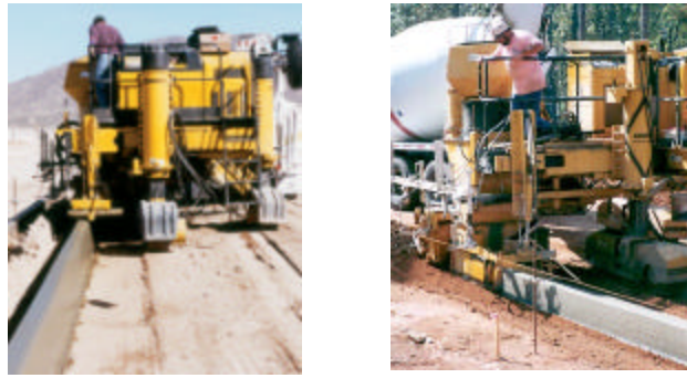
Figura S.1 Máquinas extruidoras autopropulsadas con cimbra deslizante para la construcción de guarniciones.
