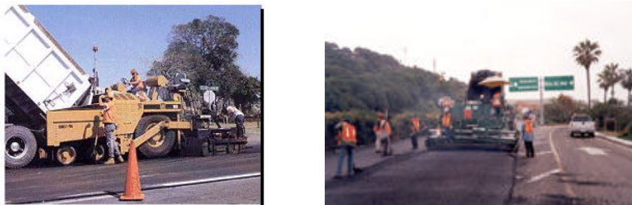
Figura O.4 Tendido de la mezcla asfáltica.
