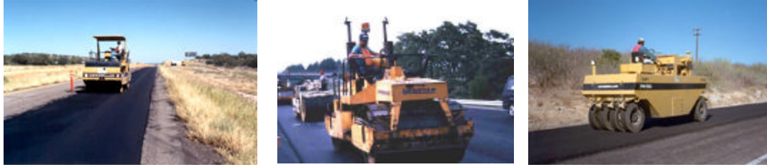
Figura O.5 Trabajos de compactación de la mezcla asfáltica.
