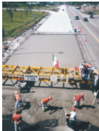
Figura Q.3 Colocación de concreto hidráulico con regla vibratoria autopropulsada.
