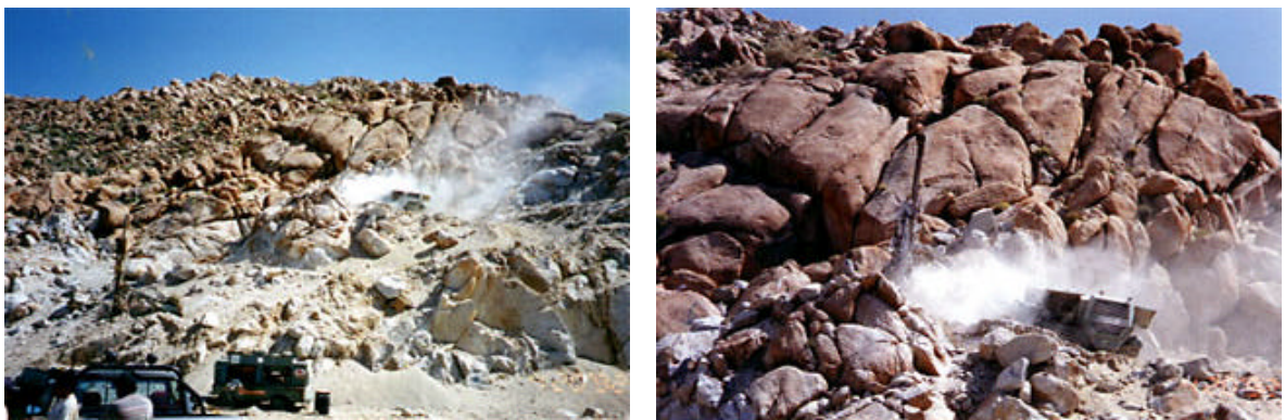
Figura E.2 Trabajos de demolición utilizando explosivos.
