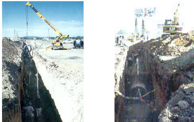
Figura T.6 Maniobras para la colocación de tubos de concreto para alcantarillas.
