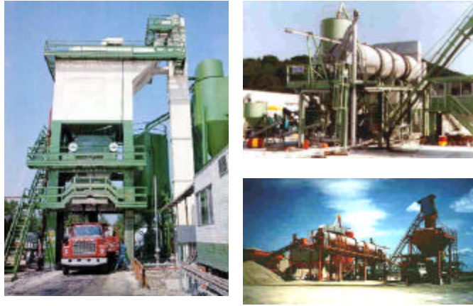
Figura O.3 Planta central para la elaboración de mezcla asfáltica en caliente.
