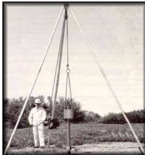
Figura B.2 Estudios de campo para la mecánica de suelos.
