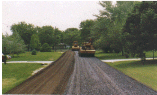
Figura G.3 Estabilización de materiales pétreos para conformar la capa de base.
