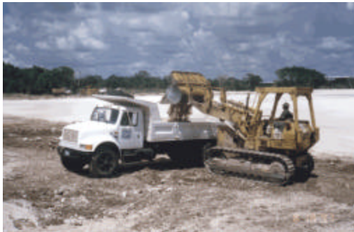
Figura F.3 Trabajos de carga y acarreo del material excedente producto de los cortes.
