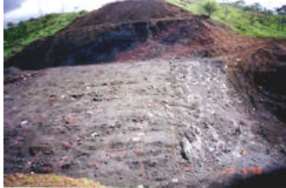
Figura F.1 Despalme de la superficie de trabajo.
