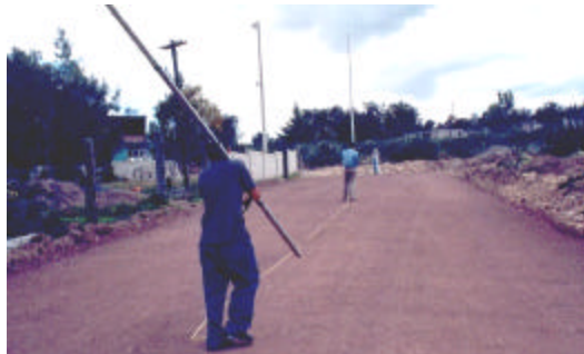
Figura F.5 Revisión de niveles de la sub-rasante.
