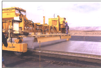
Figura Q.11 Proceso de curado con membrana química.
