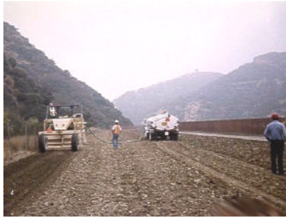
Figura H.1 Construcción de una capa formada por material de revestimiento.
