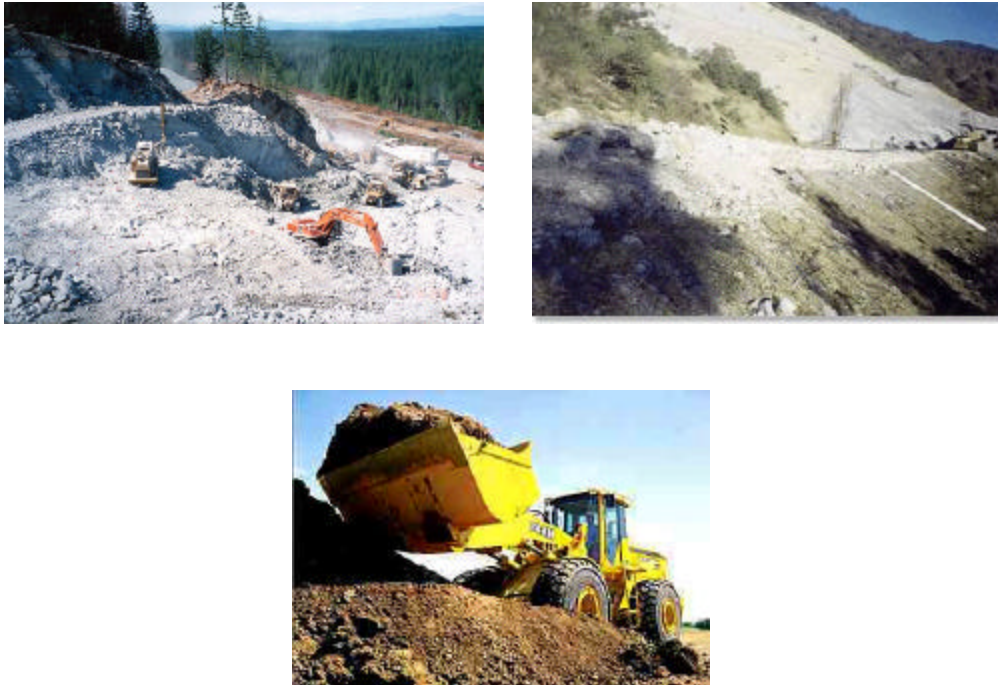
Figura F.6 Construcción de terraplén.
