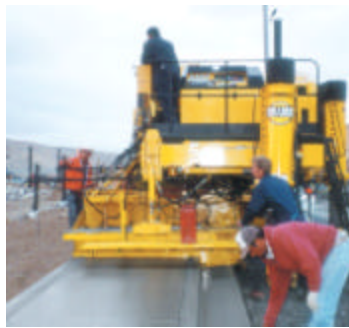
Figura S.2 Máquinas extruidoras autopropulsadas con cimbra deslizante para la construcción de guarniciones y banquetas.
