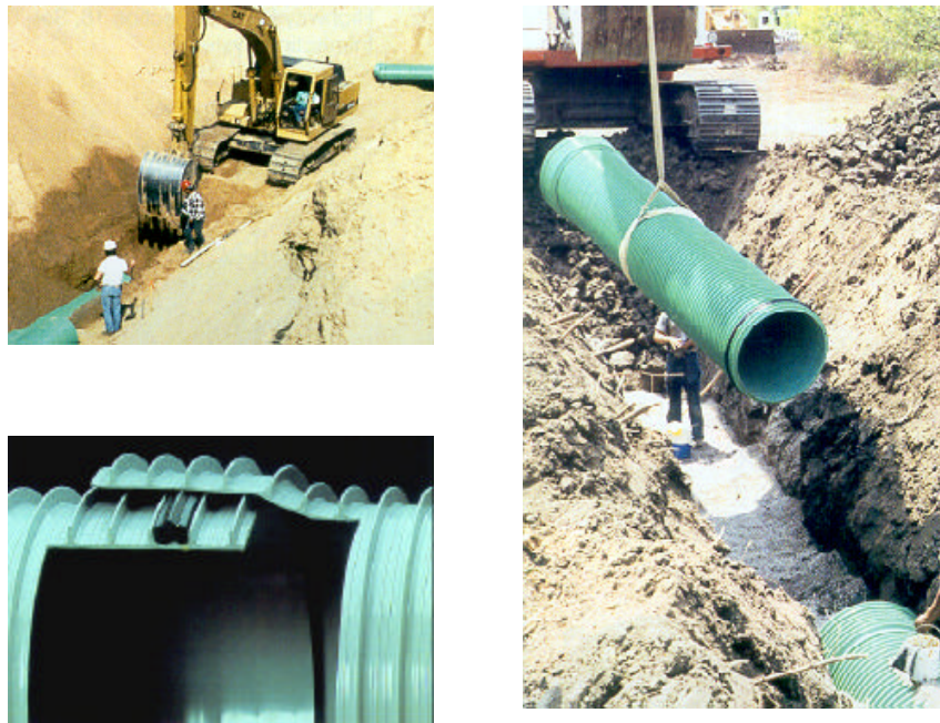
Figura T.8 Alcantarillas tubulares de policloruro de vinilo.
