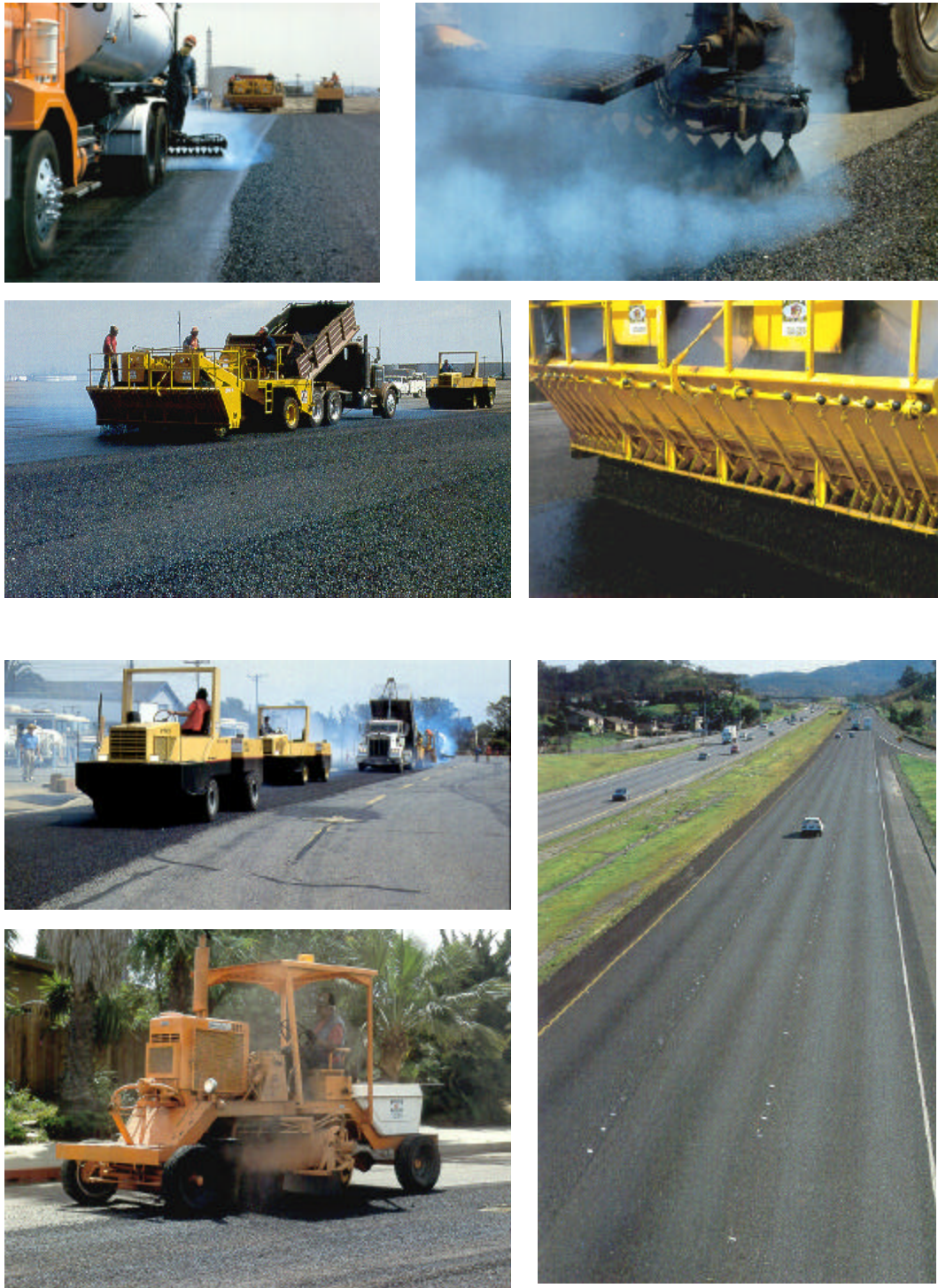
Figura M.1 Etapas durante la aplicación del riego de sello.
