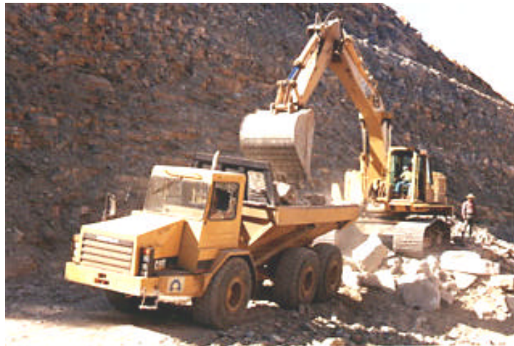
Figura E.3 Carga y acarreo de material producto de las demoliciones.
