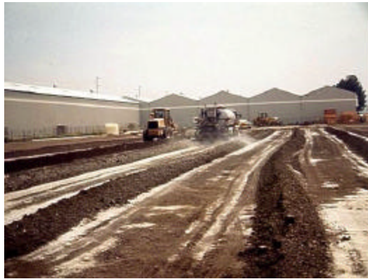
Figura F.4 Tratamiento de material para construcción de la sub-rasante.
