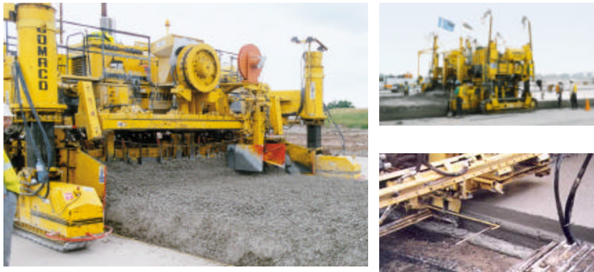
Figura Q.7 Colocación de concreto hidráulico con pavimentadora.
