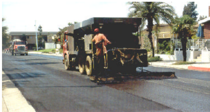
Figura N.2 Aplicación de mortero asfáltico.
