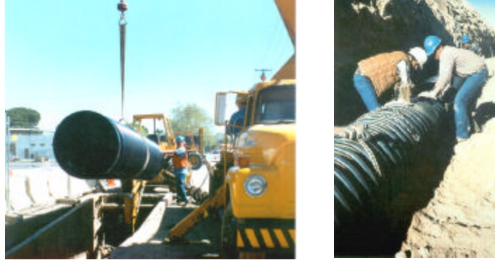
Figura T.7 Alcantarillas tubulares de polietileno de alta densidad.
