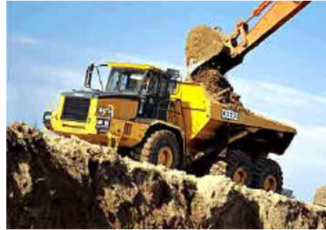
Figura F.3 Trabajos de carga y acarreo del material excedente producto de los cortes.
