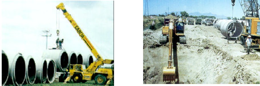
Figura T.6 Maniobras para la colocación de tubos de concreto para alcantarillas.
