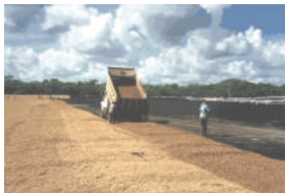
Figura T.5 Tendido de material granular para la construcción de una capa drenante.
