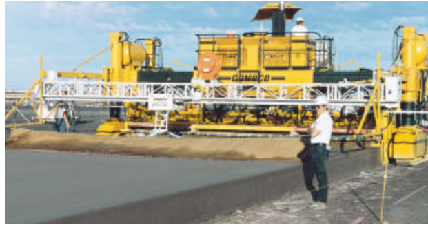
Figura Q.8 Rastra para el microtexturizado longitudinal.
